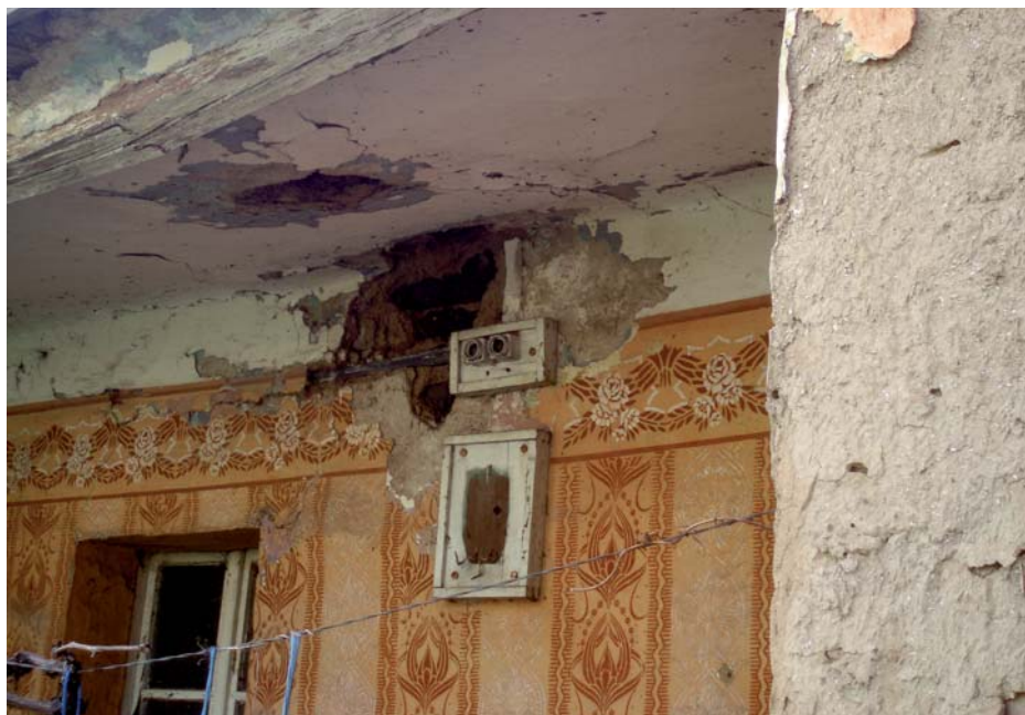
Dotrajale električne instalacije u zemljanom zidu
