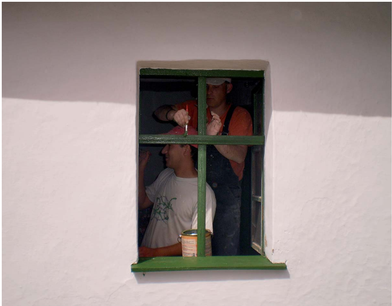
Obnova prozora u Topolju
