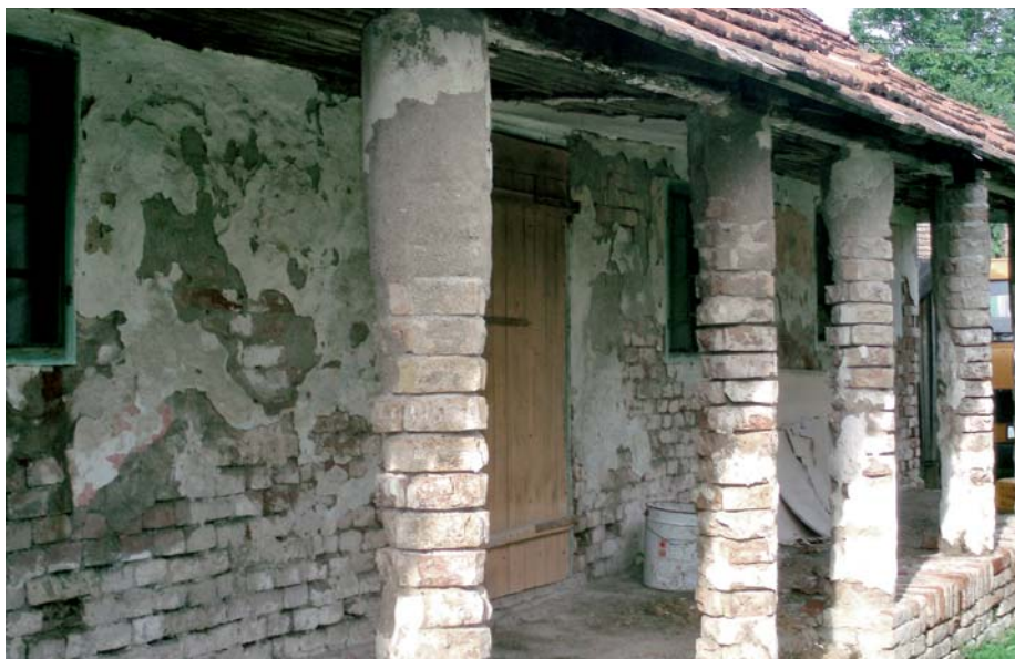
Trijem s okruglim zidanim stupovima, Gradište
