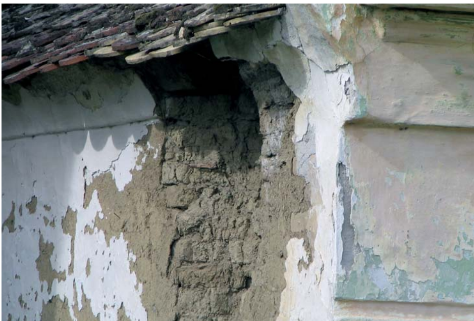
Propadanje zida od ćerpiča zbog nepostojanja žljeba, Kopačevo
