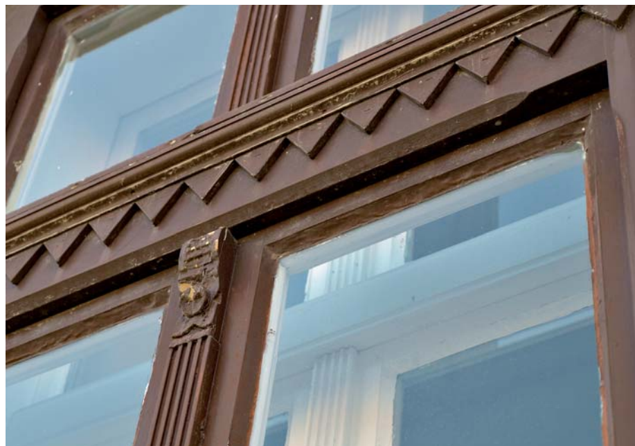
Detalj obnovljenog prozora, Topolje
