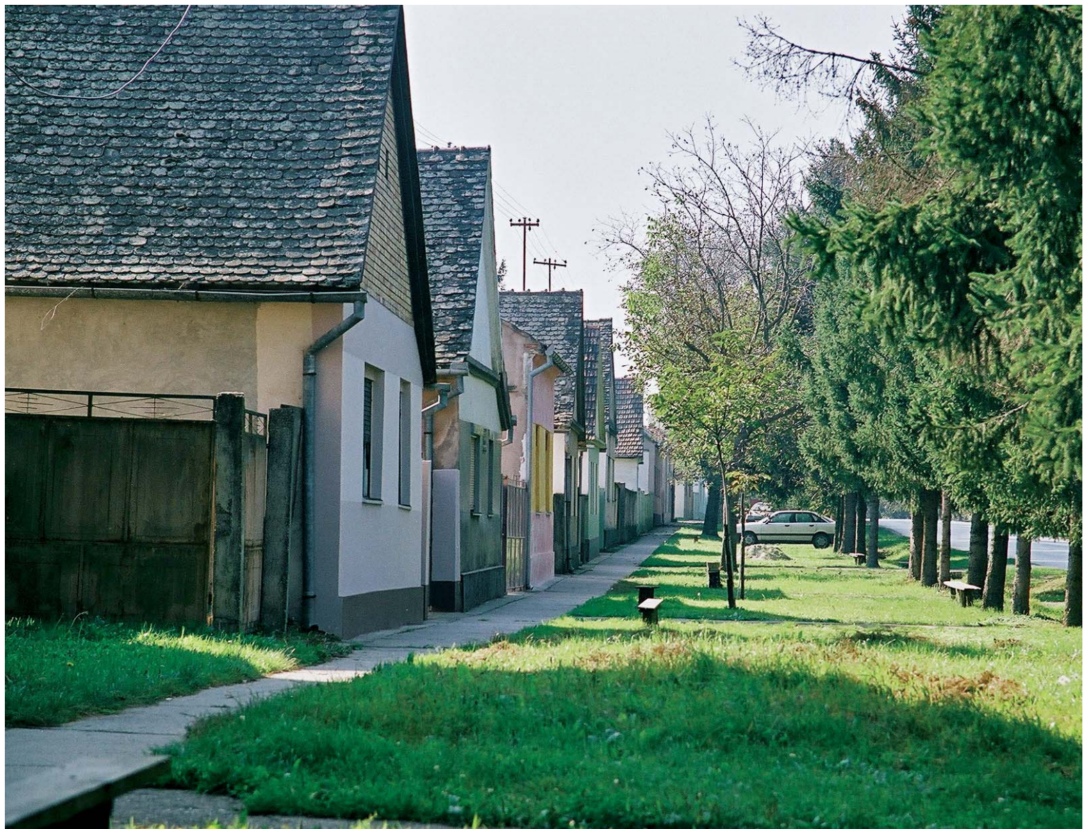
Ritam krovišta slavonske ulice
