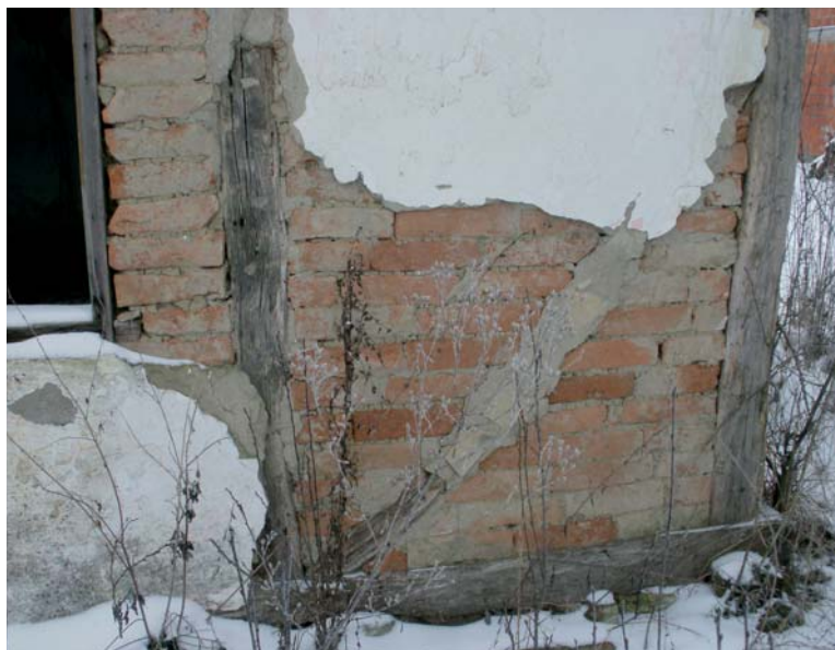
Podsjek ispod kanatnog zida, Normanci
