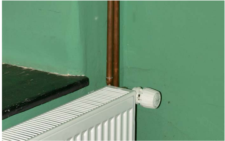
Instalacija centralnog grijanja, Čeminac
