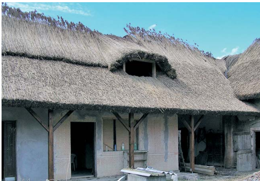
Savijanje trske u sljemenu
