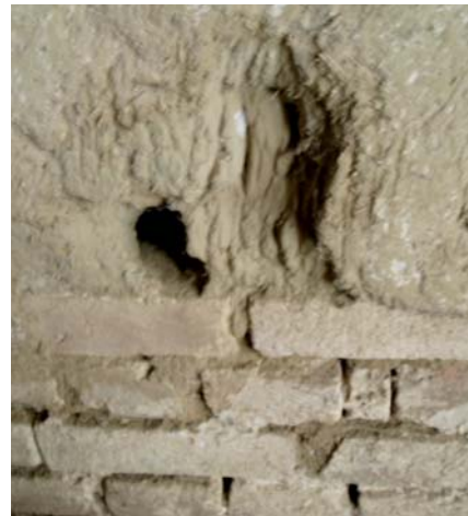
Rupe u zidu od nabijače – oštećenje od štakora, Kneževi Vinogradi
