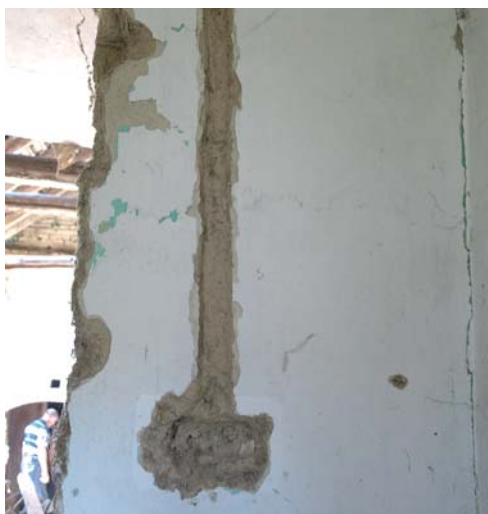
Usječeni zid o nabijače za elektroinstalaciju, Batina
