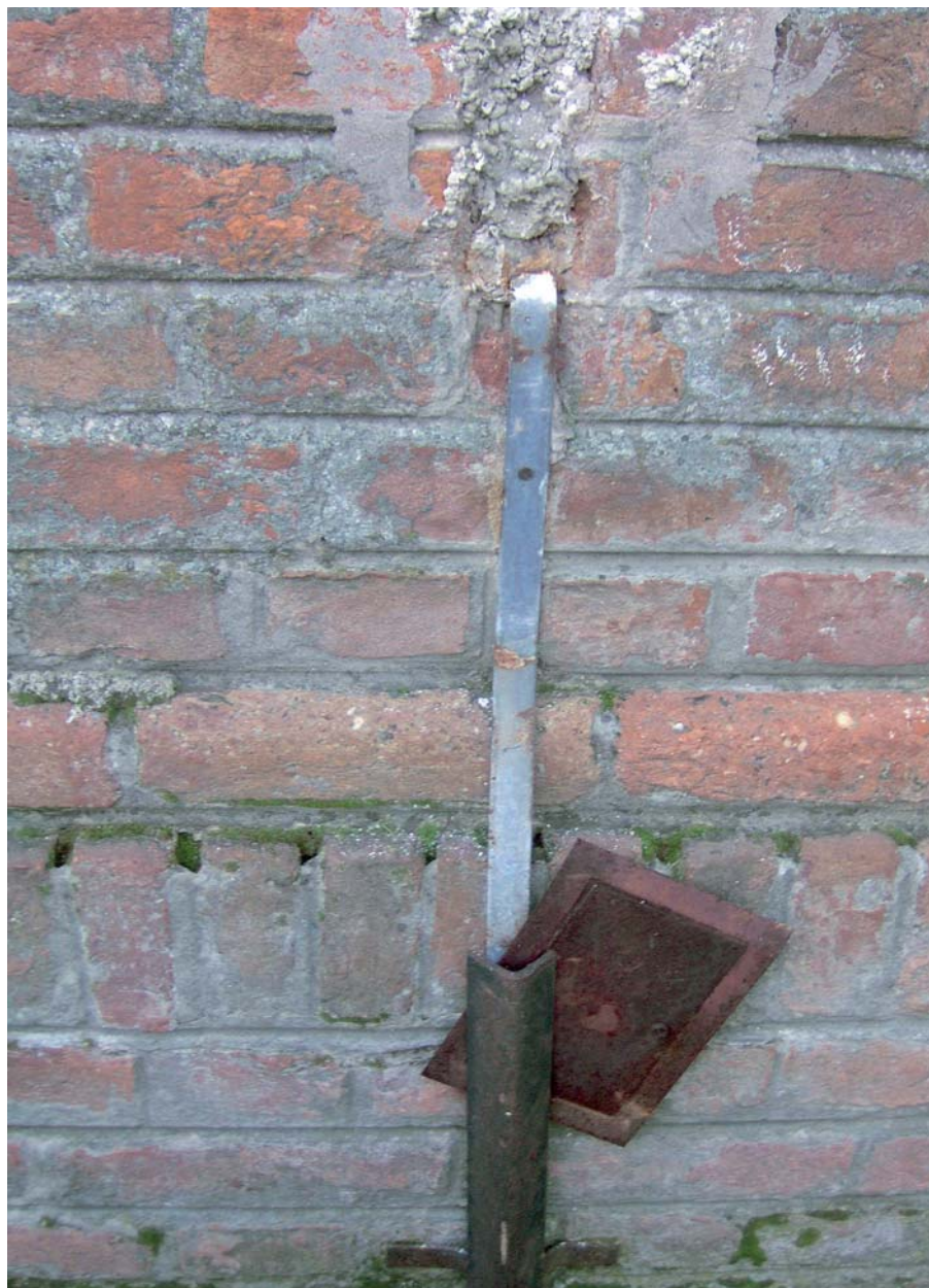
Oštećenje zida uslijed korozije gromobranske instalacije, Bilje
