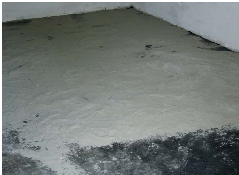
Postavljanje pijeska na hidroizolaciju, Topolje
