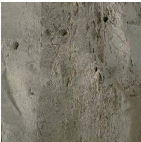
Rupe za sanaciju vlage u zidu kemijskim putem, Aljmaš
