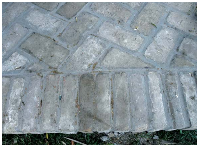
Novi pod od opeke, Kopačevo
