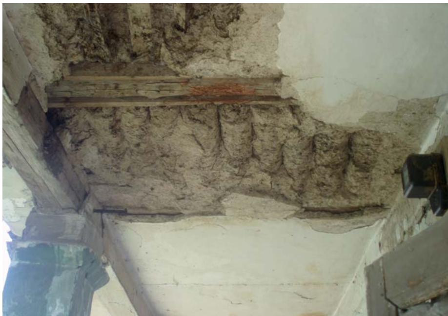
Strop s vitlovima, Tovarnik
