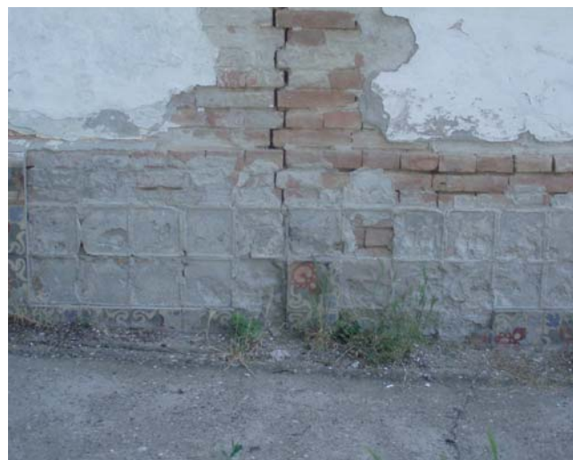
Pukotina u nadtemeljnem zidu uslijed oštećenja temelja, Lovas
