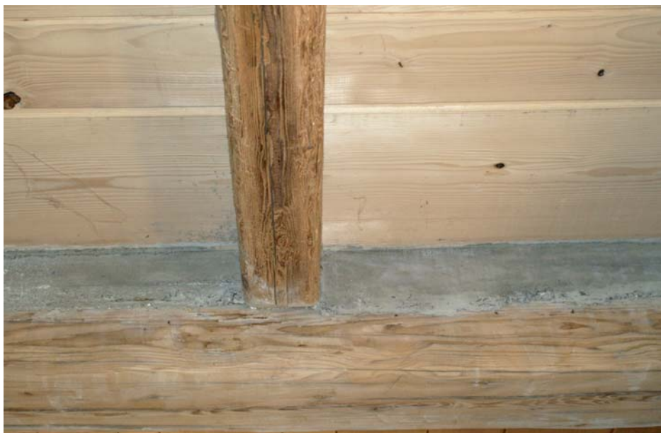
Sprezanje armiranobetonske i drvene grede
