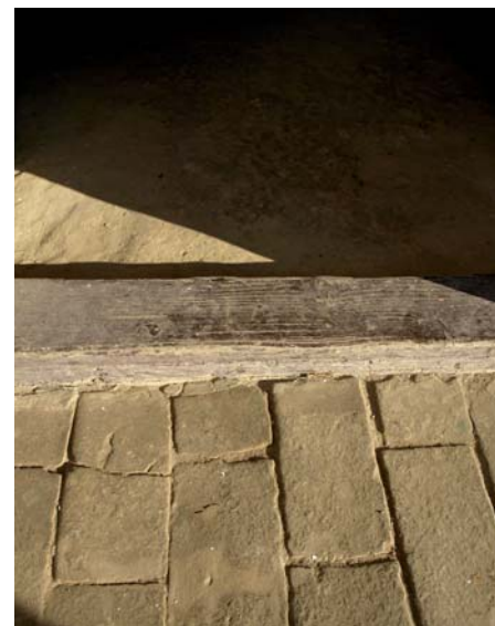
Spoj poda od opeke i zemljanog poda
