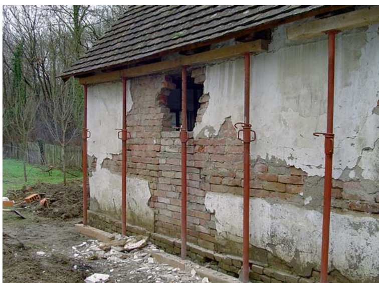
Priprema za sanaciju koljebe u Etno parku Dretvića stan
