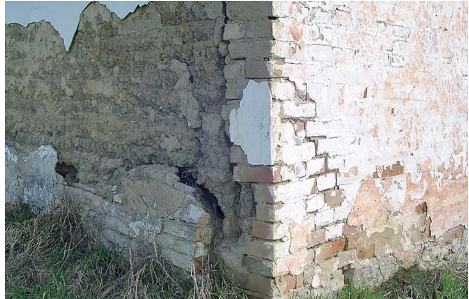
Pukotina na mjestu spoja zidova od različitih materijala, Luč
