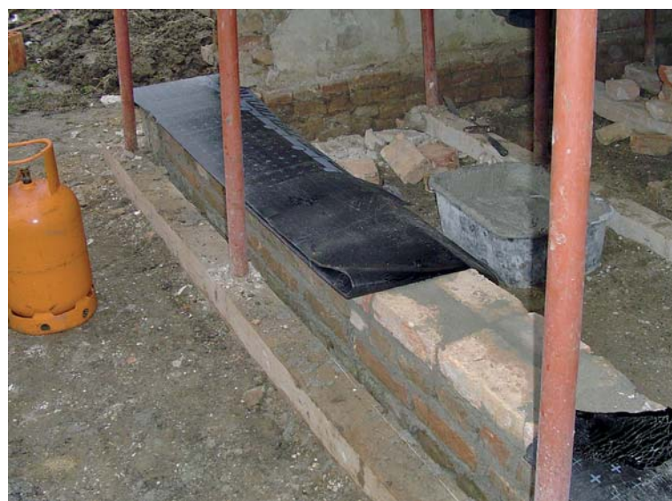
Postavljanje hidroizolaciju na sanirane temelje koljebe u Etno parku Dretvića stan
