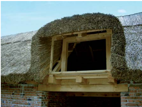
Krovni istak prije i poslije pokrivanja trskom
