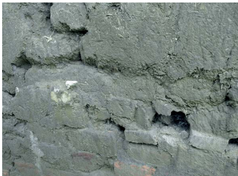
Zid od nabijače na temelju od opeke, Kopačevo
