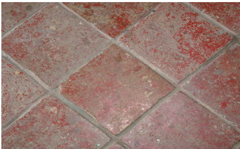
Pod trijema od četvrtaste opeke, Čeminac
