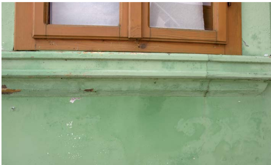
Vlaga u zidu zbog lošeg rješenja vanjske klupčice, Aljmaš
