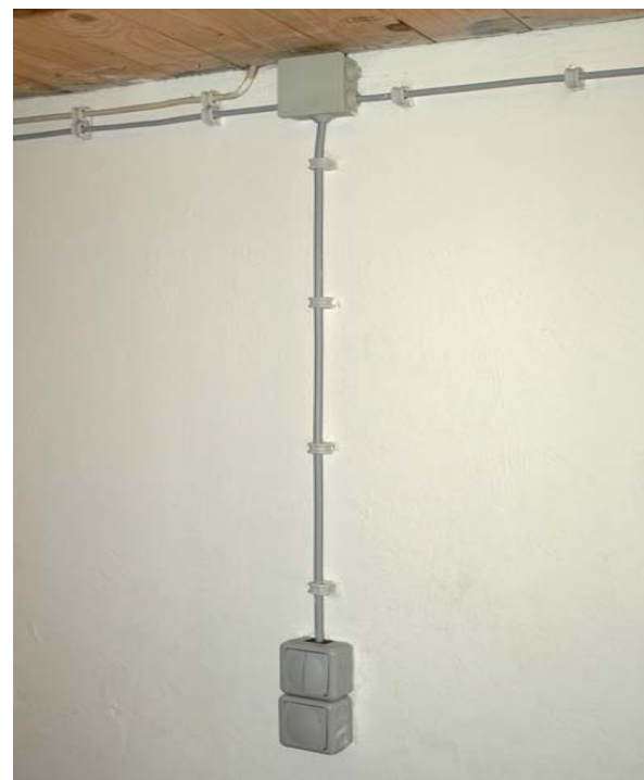
Vanjski razvod električnih instalacija, mlin Suza
