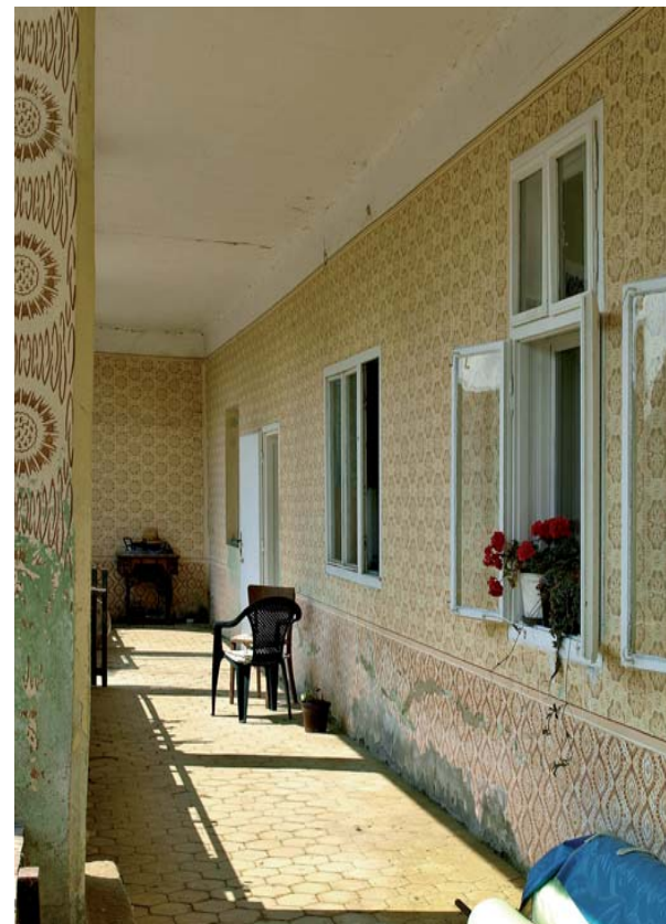
Pod trijema od šesterokutne opeke, Kopačevo
