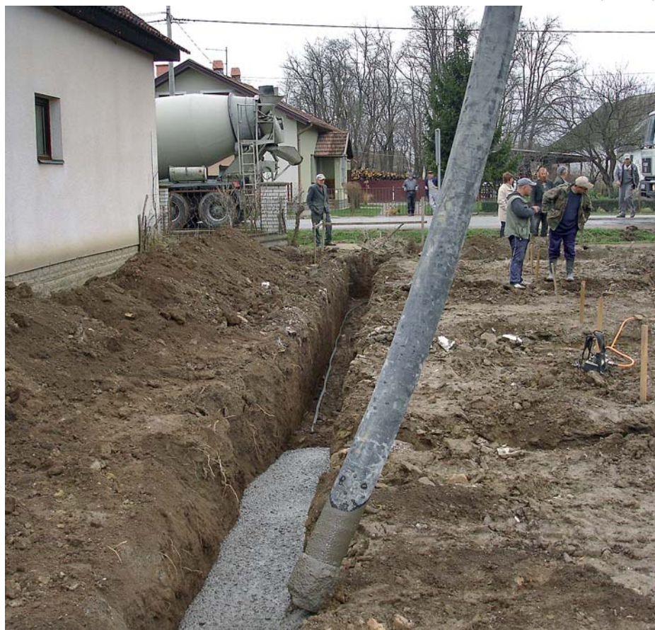
Betoniranje temelja
