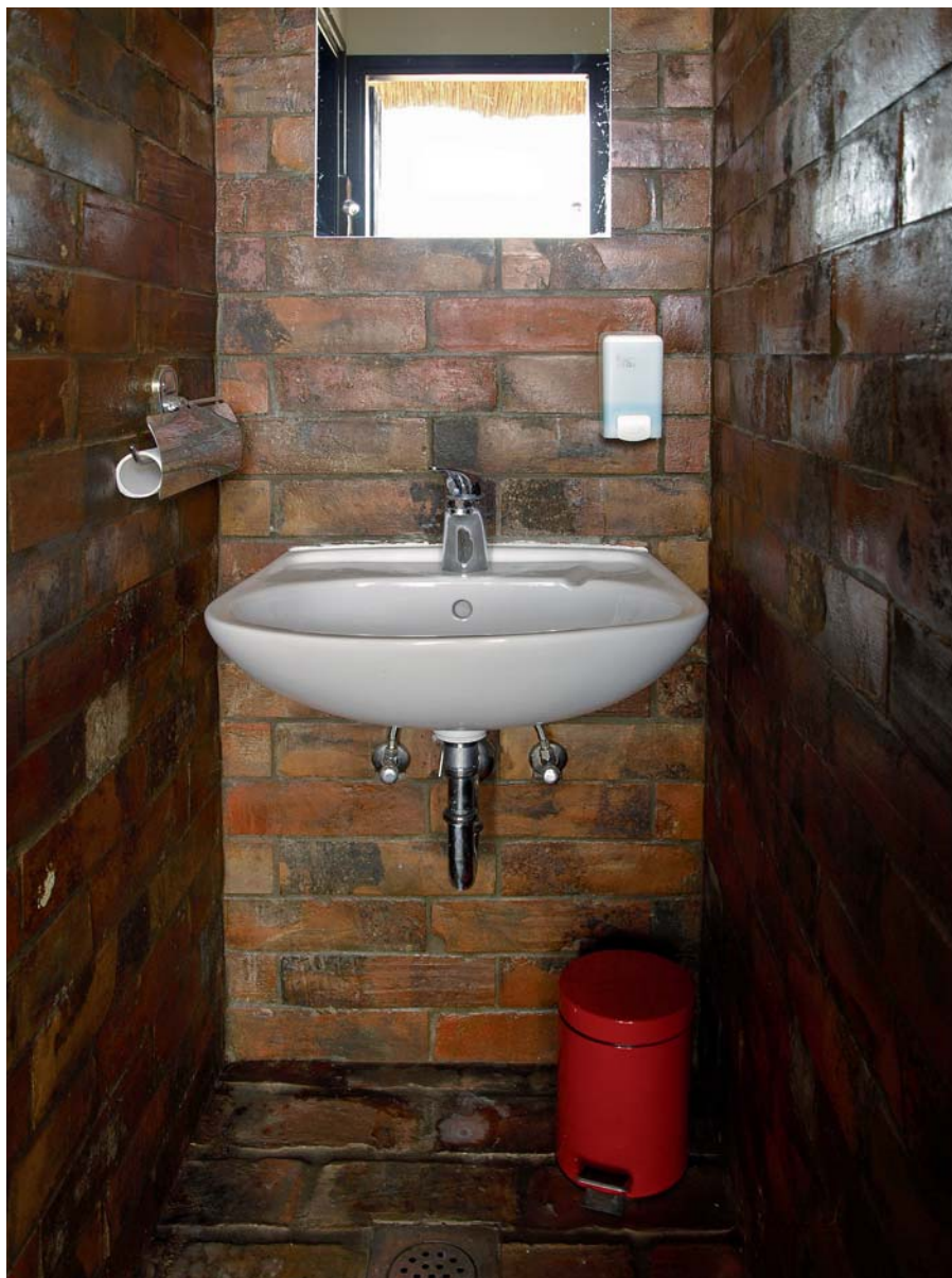
Novi sanitarni čvor, obloga crijepom premazanim lanenim uljem, Čeminac
