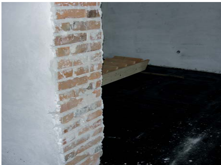
Postavljanje hidroizolacije novog poda od opeke, Topolje
