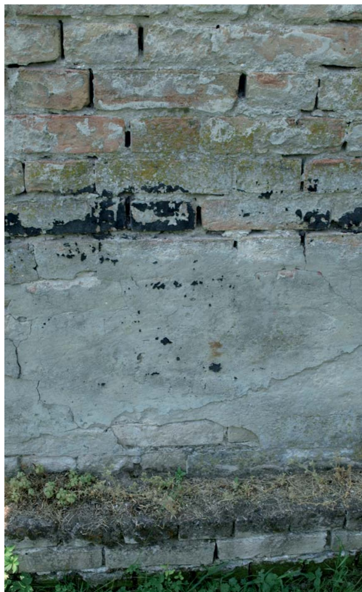
Otkopani temelj mlina u Suzi, dotrajala hidro izolacija
