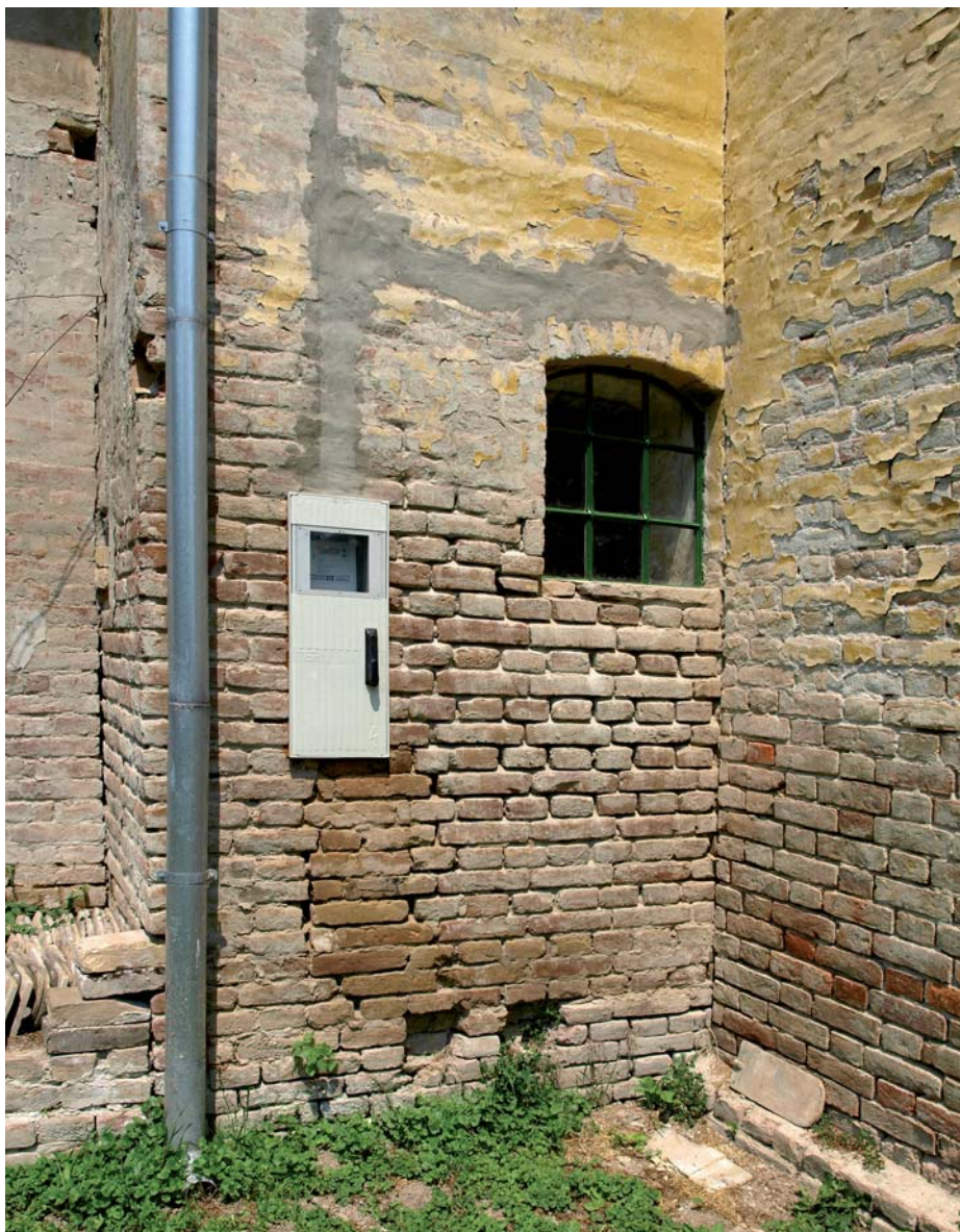
Razvodni ormarić na stražnjem dijelu mlina u Suzi
