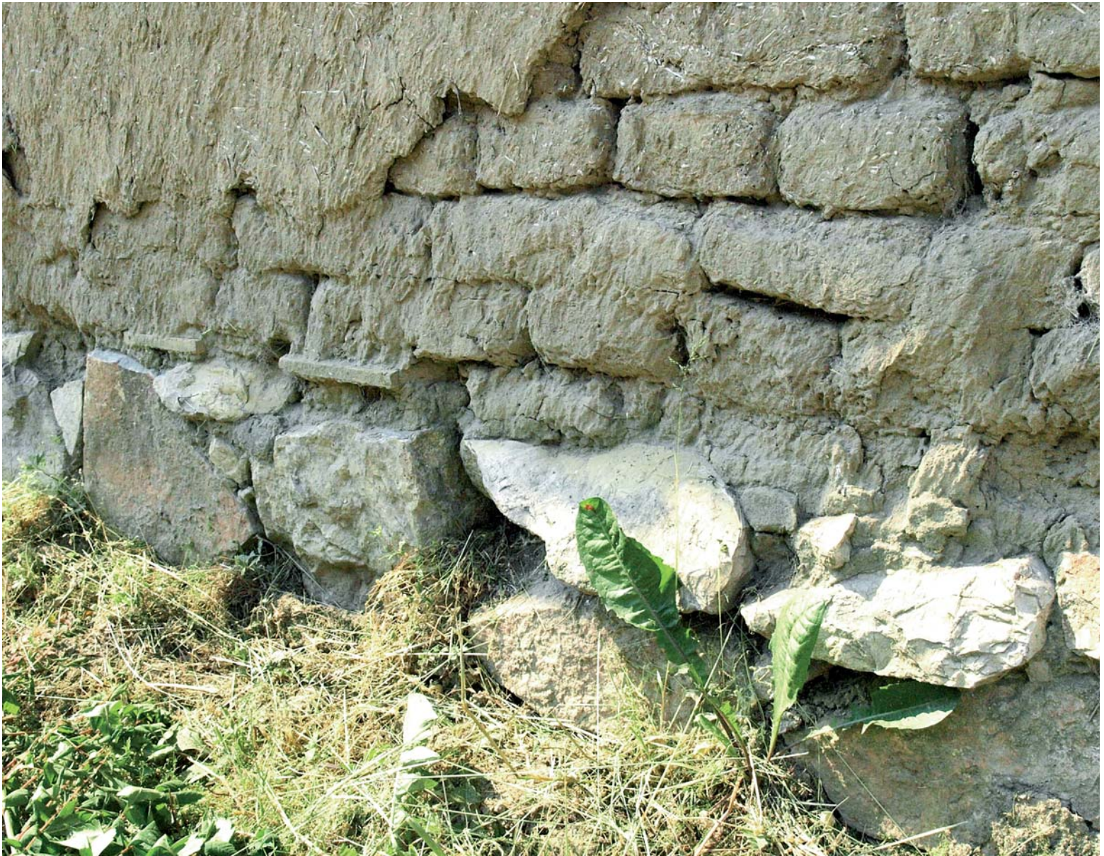
Zid od ćerpiča na temelju od kamena, Kopačevo
