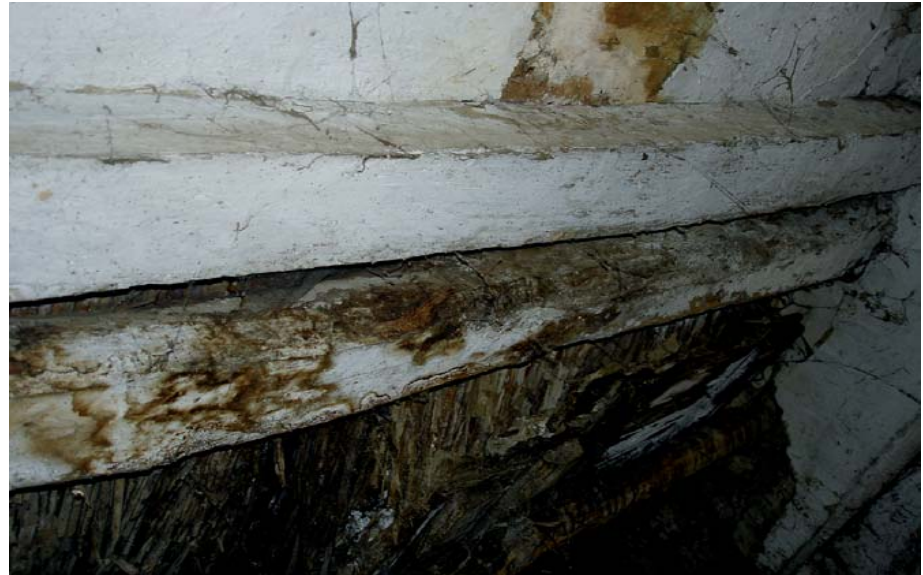
Drveni grednik uništen utjecajem vlage, Topolje
