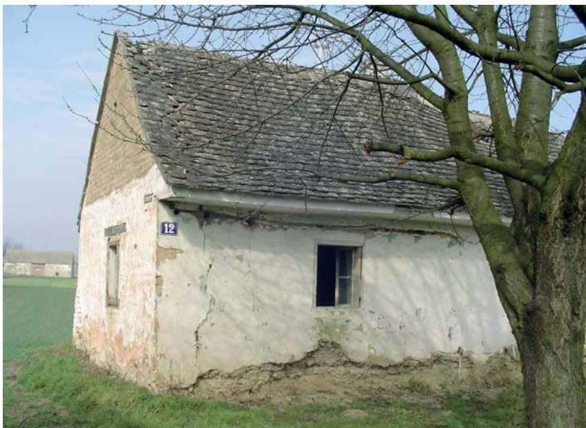
Propadanje temelja uslijed utjecaja vlage, Luč
