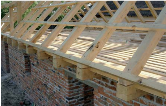
Krovnja konstrukcija staje s kolnicom
