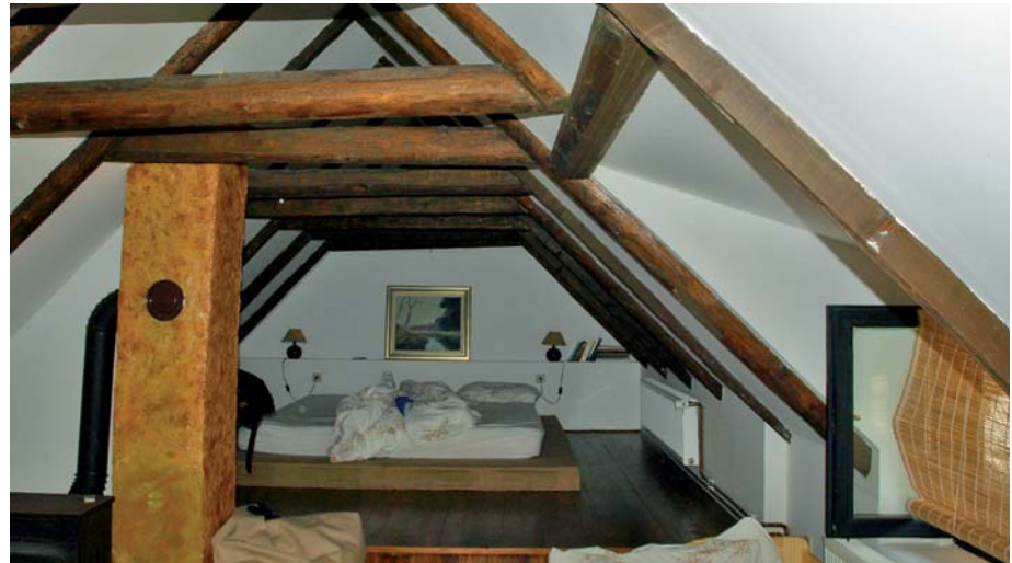
Prenamjena potkrovlja u stambeni prostor, Čeminac
