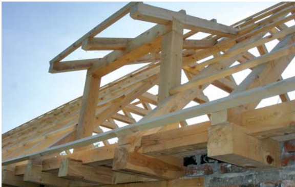
Krovni istak prije i poslije pokrivanja trskom
