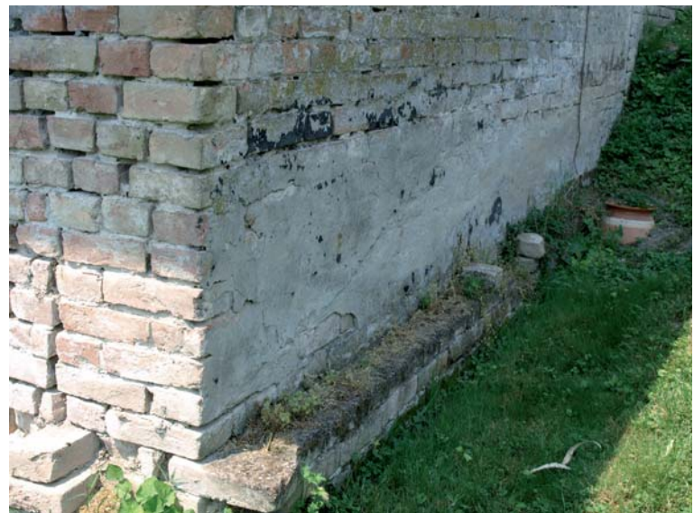
Pukotina u nadtemeljnom zidu uslijed oštećenja temelja, Suza
