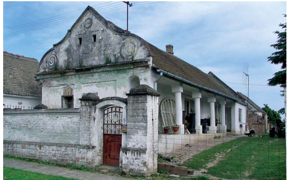
Trijem s okruglim zidanim stupovima, Lug
