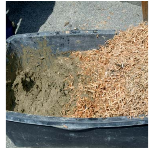
Elementi smjese za sanaciju zida od čerpiča
