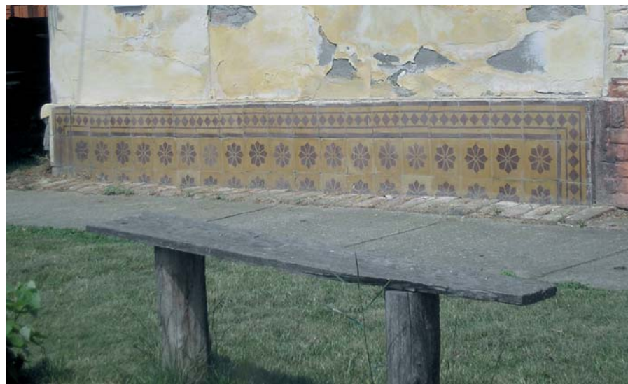
Oblaganje nadtemelnog zida keramikom
